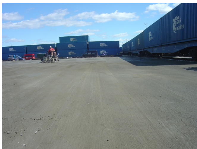
Rys. 4.9. Zacieranie i teksturowanie nawierzchni z betonu. Fot. Autor
