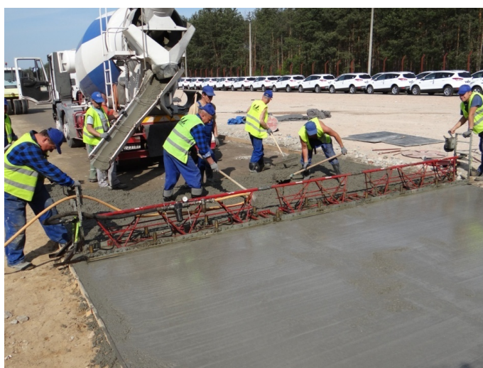
Rys. 4.2. Formowanie nawierzchni kompozytowej przy użyciu pneumatycznej listwy wibracyjnej z przesuwem wciągarkowym. Fot. Autor
