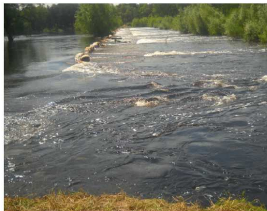
Bild 5: Lücke am rechten Widerlager des Deichüberlaufs in Kraśnica
