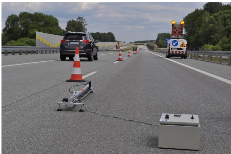
Pomiary makrotekstury nawierzchni stacjonarnym profilografem laserowym na drodze ekspresowej S8 (odcinek Pabianice – Sieradz, woj. łódzkie)
