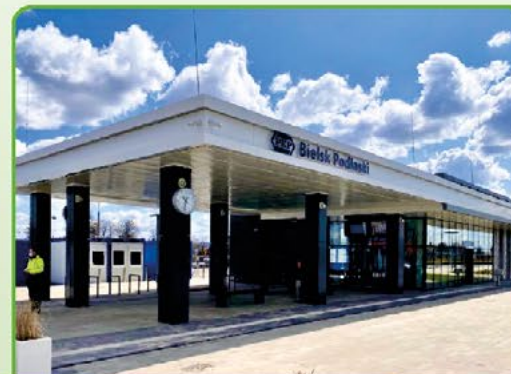
Budowa dworca kolejowego w Bielsku Podlaskim
