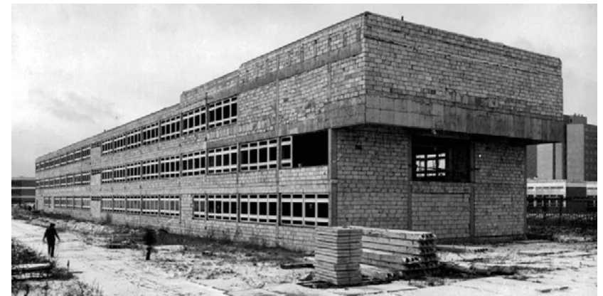
Budowa siedziby Wydziału przy ul. Wiejskiej 45 E
