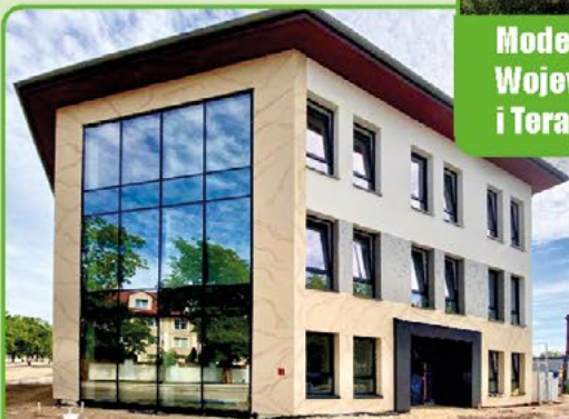
Budowa siedziby Placówki Terenowej KRUS w Łomży
