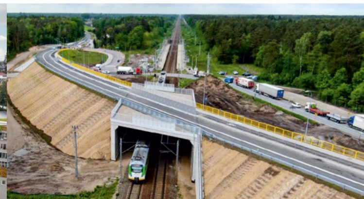
Wiadukt nad torami, Topór, Polska
